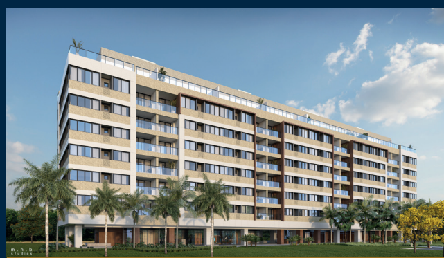
Singular Noroeste Setor Noroeste (em obras)
