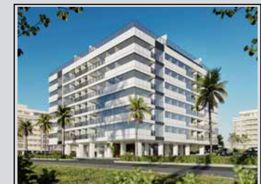
Illuminato Noroeste Setor Noroeste (em obras)
