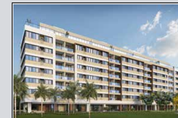
Singular Noroeste Setor Noroeste (em obras)
