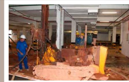
Moldadas no solo, são executadas por meio de processo rotativo com circulação de água. A estaca é armada e preenchida com calda de cimento, injetada sob pressão. Sua grande vantagem é a praticidade, possibilidade de utilização em qualquer tipo de solo e em lugares de difícil acesso.
