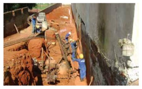
A execução de reforço de fundações através de estacas raiz ou micro estacas injetadas atende a necessidade dos mais diversos tipos de obras onde há limitação de acesso e altura e nível d'água.
