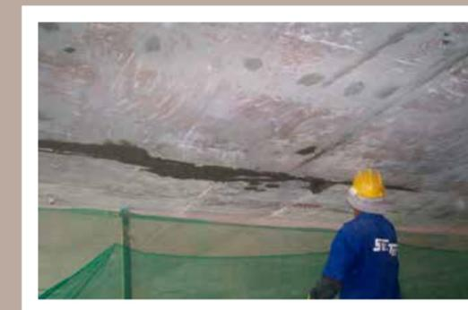
Alta densidade da armadura, consistência inadequada e más condições de transporte, lançamento e adensamento podem causar falhas na uniformidade da compactação do concreto, comprometendo sua resistência e durabilidade.
