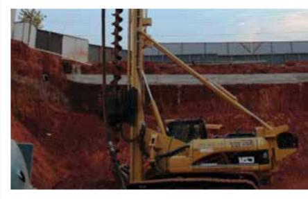
Moldada in loco, sua execução se dá por meio de rotação de um trado helicoidal contínuo e de injeção de concreto pela própria haste central do trado, simultaneamente à sua retirada. Este tipo de estaca possui uma excelente produtividade quando comparada a outros tipos de fundação, podendo ser executada abaixo no nível de água, suportando carregamentos consideráveis.
