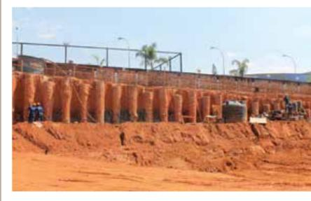
Este mecanismo constitui-se em estabilização rápida, temporária ou permanente de taludes naturais ou escavações. Trata-se da introdução de chumbadores em um maciço de solo, associado à aplicação de concreto projetado armado na face deste maciço.
