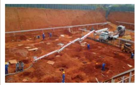
São elementos estruturais de fundação profunda constituídos geralmente de fuste e base alargada. São executados a céu aberto e possuem grande capacidade de carga.
