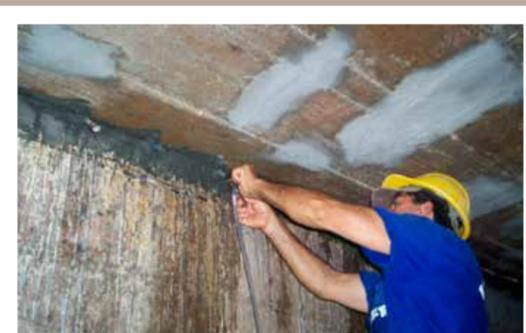
Fissuras e trincas são os problemas mais comuns nas estruturas de concreto armado, e podem se manifestar desde poucos dias a até muitos anos após a concretagem. As causas são diversas: movimentações térmicas da estrutura, sobrecargas, recalques, problemas de projeto, execução inadequada e diversas outras.
