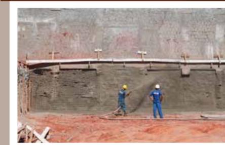
O concreto projetado acomoda-se à superfície natural do terreno, e dispensa a utilização de formas. Possui alta resistência inicial e é largamente utilizado na estabilização e combate ao desmoronamento de maciços de solo e taludes.
