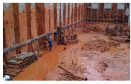
Caracteriza-se pela execução por perfuração rotativa com uso de tubos metálicos recuperáveis, completada por colocação da armação ao longo de todo comprimento e preenchimento com argamassa de cimento e areia. São geralmente utilizadas em contenções, fundações e reforço de fundações, tendo como vantagens o fato de não produzir vibrações no terreno.
