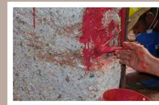
A corrosão da armadura é um processo eletroquímico que ocorre na presença da água e oxigênio. Alta permeabilidade do concreto, falhas na elaboração dos projetos e de execução, baixos recobrimentos da armadura e existência de fissuras são as principais causas de corrosão da armadura.
